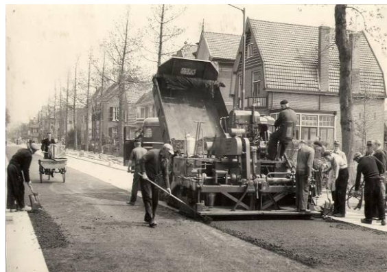
In 1955 werd een laag bitumen gestort.
