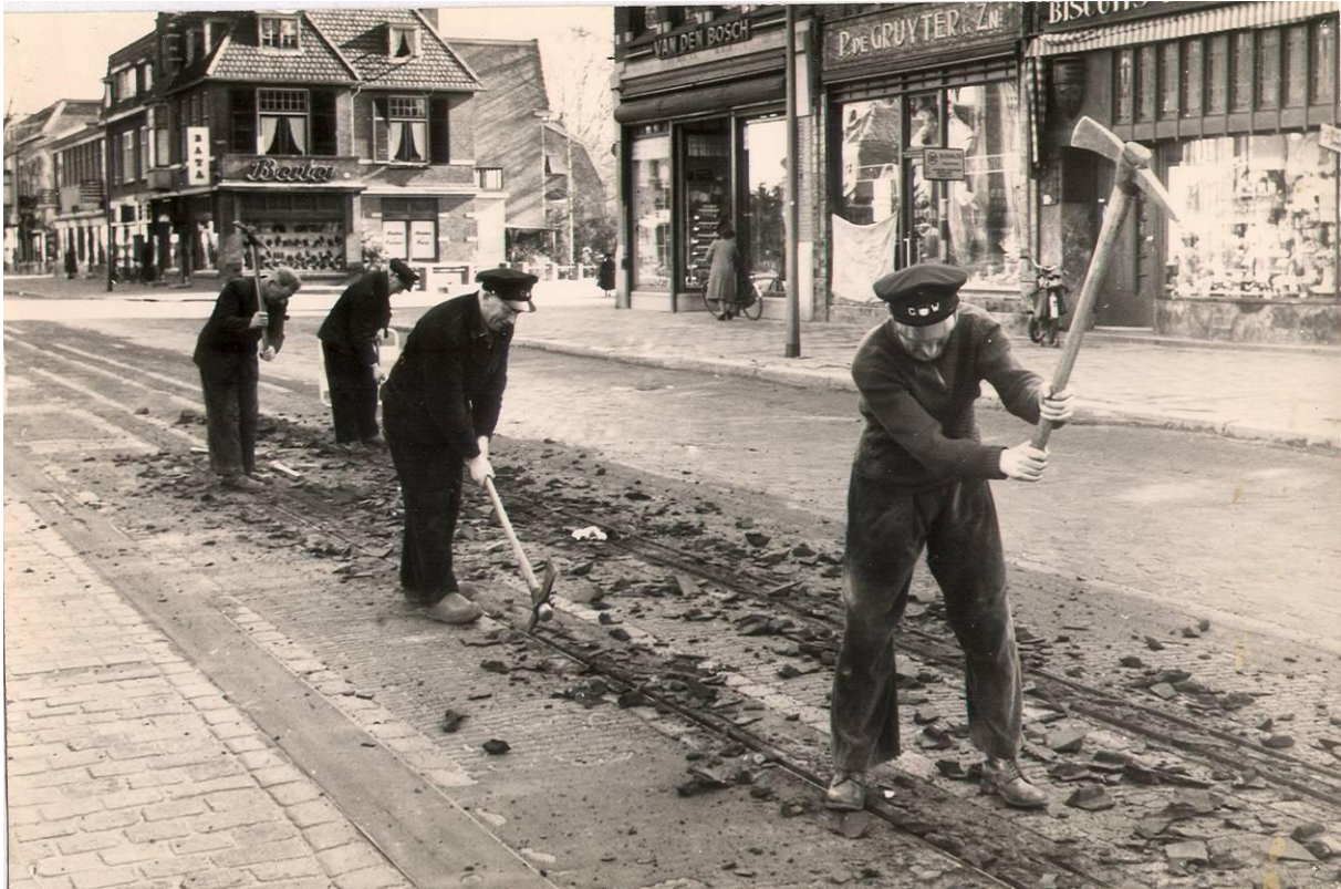
Weghakken van de tramrails i.v.m. verbreding van de Slotlaan.
